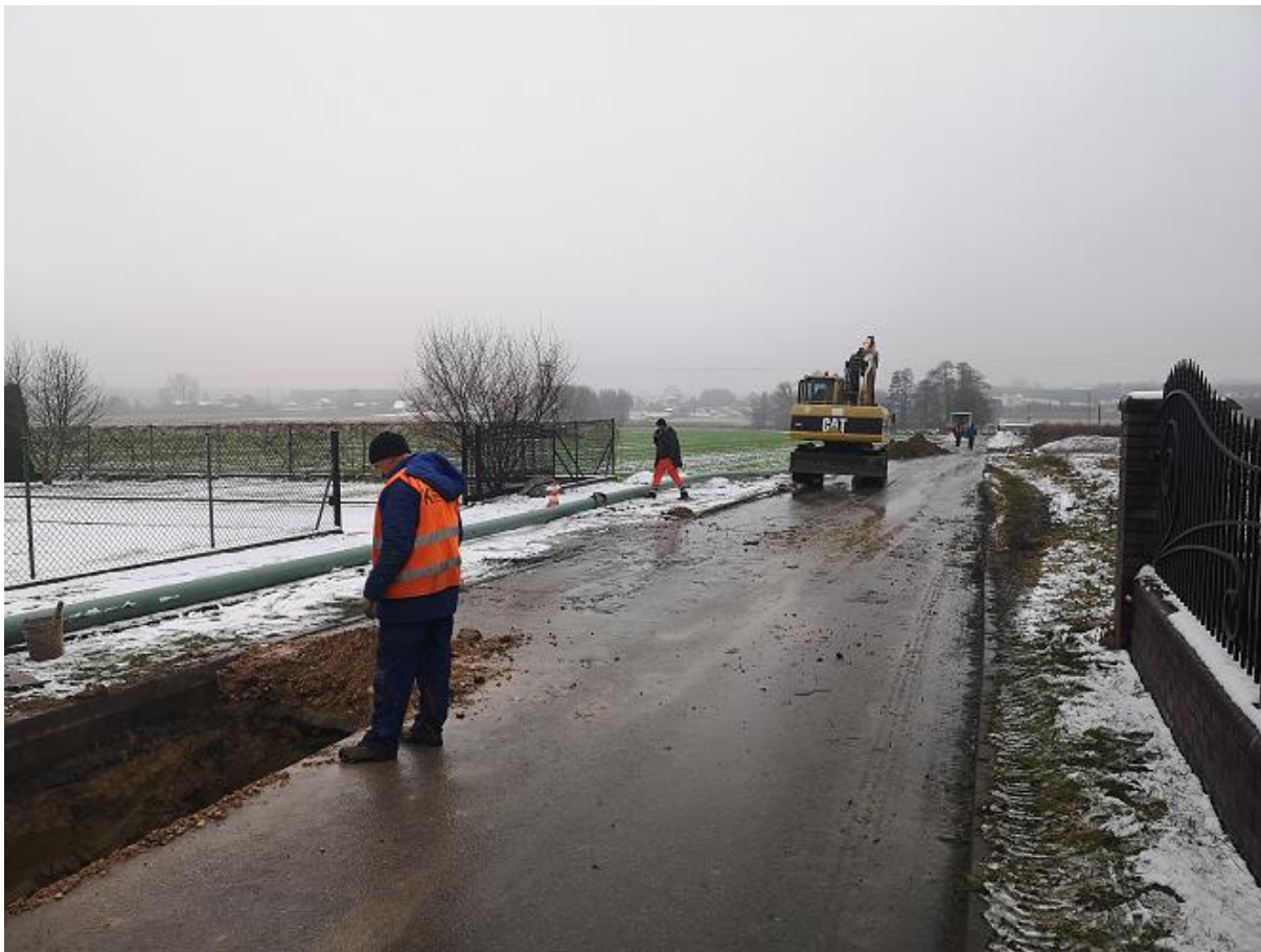
Zdjęcie: budowa kanalizacji w m. Rozprza
